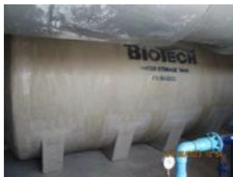
ภาพถ่ายที่ 2.2-59 ถังสำรองน้ำใช้บนหลังคา
