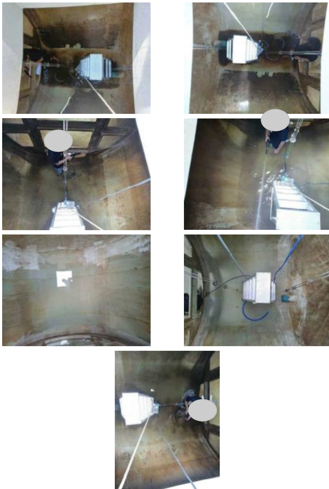
ภาพถ่ายที่ 2.2-76 การล้างทำความสะอาดถังเก็บน้ำใช้
