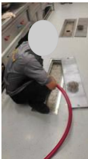
ภาพถ่ายที่ 2.2-20 เจ้าหน้าที่ตักไขมันในบ่อดักไขมัน (Grease trap tank)
