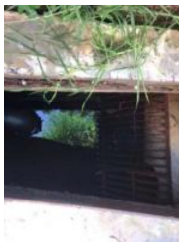
ภาพถ่ายที่ 2.2-63 ตะแกรงดักขยะที่บ่อตรวจสอบภาพน้ำ
